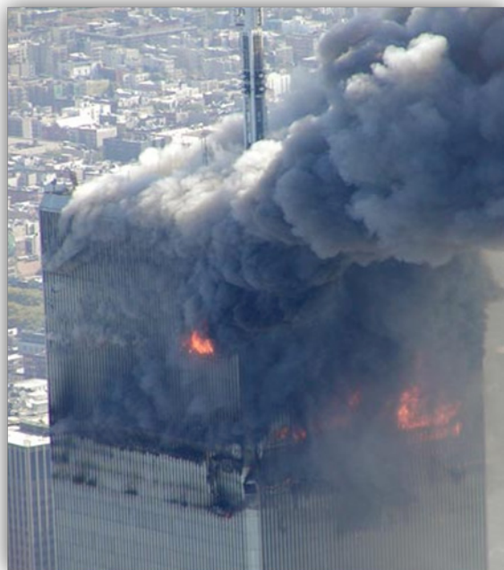
Una de las Torres a punto de colapsar
